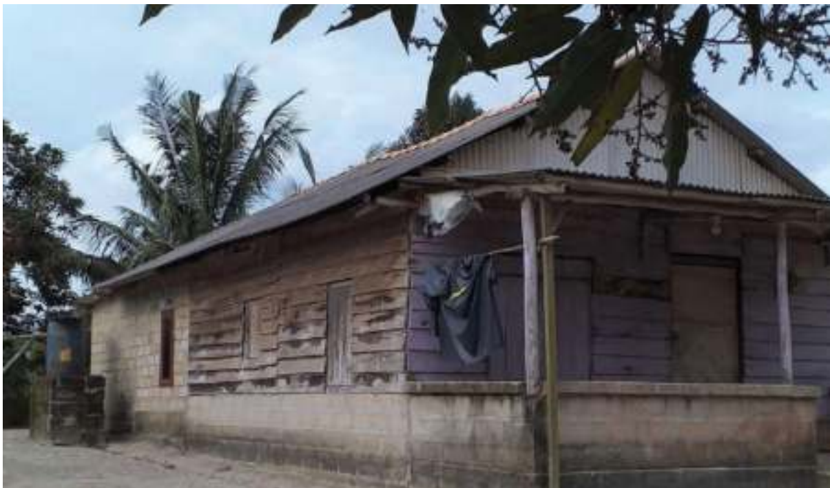
Salah satu rumah semi permanen warga Kampung Pasir, Dusun Kedimpal. (Indah Suci Safitri)
