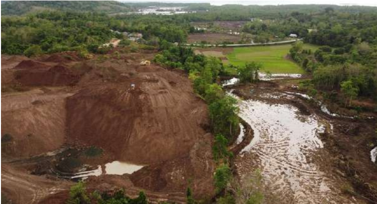
Keterangan foto: Ekskavator dan bulldoser PT Wijaya Inti Nusantara (WIN) meratakan tanah dekat sawah di Desa Mondoe, Kecamatan Palangga Selatan, Kabupaten Konawe Selatan (Konsel), Sulawesi Tenggara (Sultra), Sabtu, 22 November 2025
