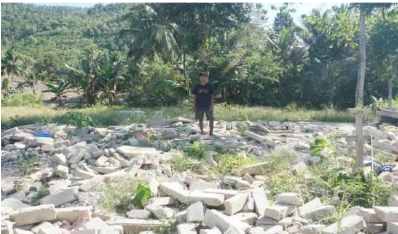
Keterangan foto: Opan Munu berdiri di puing-puing rumahnya yang hancur diterjang banjir bandang. Foto: Franco Bravo Dengo
