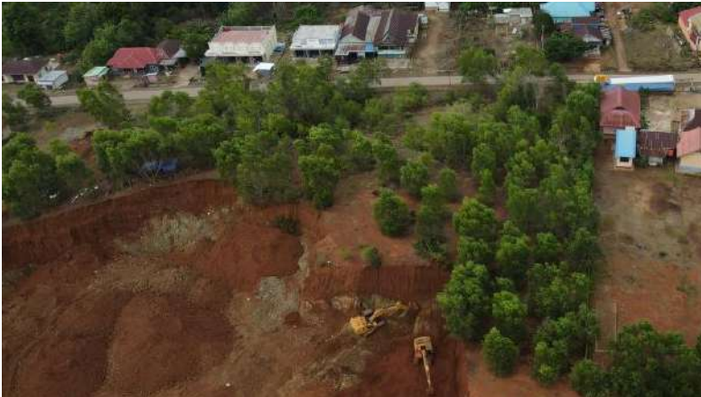
Keterangan foto: Dua ekskavator PT Wijaya Inti Nusantara (WIN) mengeruk tanah di atas lahan bekas reklamasi di samping tembok Sekolah Dasar Negeri 12 Laeya, Desa Torobulu, Kecamatan Laeya, Kabupaten Konawe Selatan (Konsel), Sulawesi Tenggara (Sultra), Sabtu, 22 November 2025.
