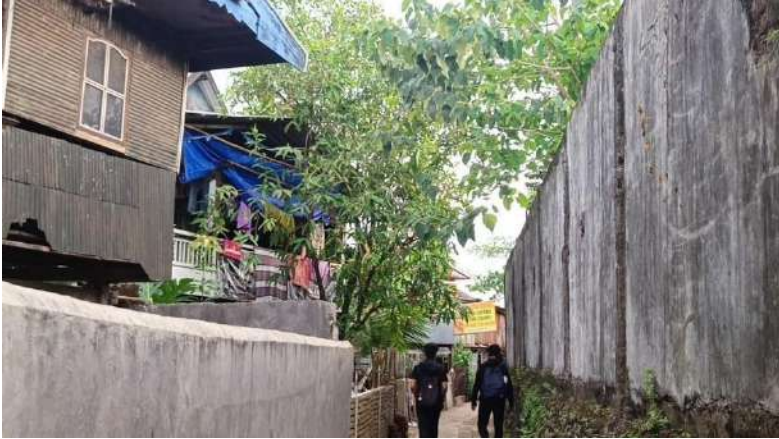
Keterangan foto: Tembok beton lokasi PLTSa (kanan) hanya berjarak 1-2 meter dari kediaman warga Kampung Mula Baru. Kota Makassar, Sulawesi Selatan.
